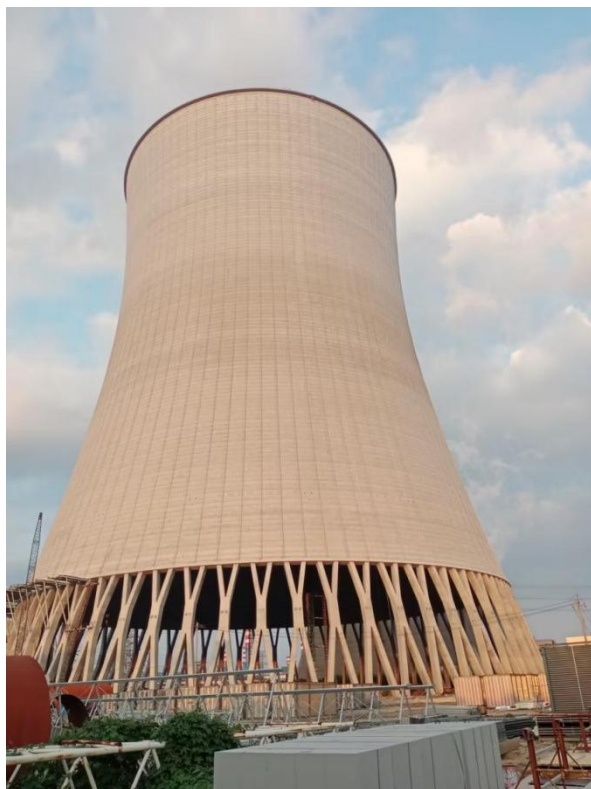
图4.6-8 山东信发信源电厂间接空冷冷却塔（塔高222m）
