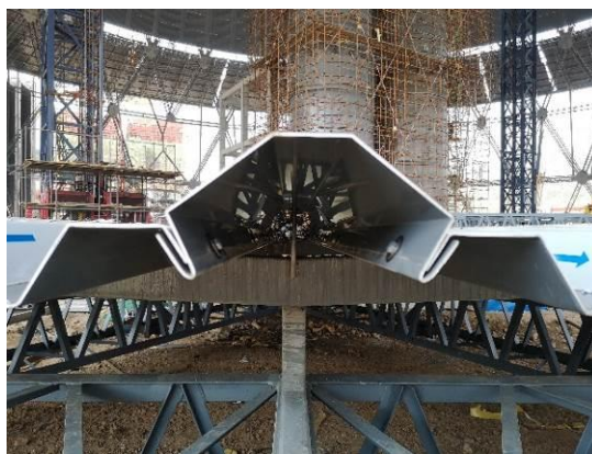
图6.5-2 接缝密封结构图
