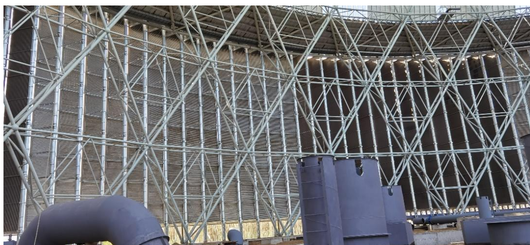
采用双向斜交网壳形式的双曲线型钢塔
