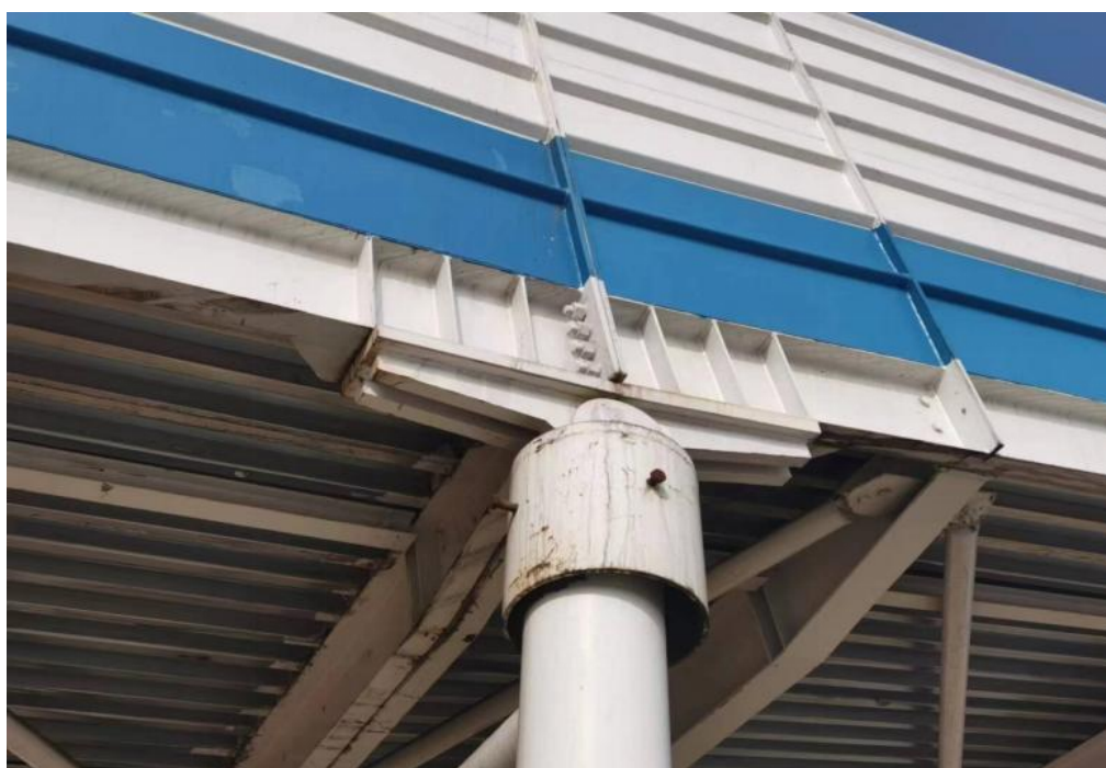
栈桥支座连接节点
