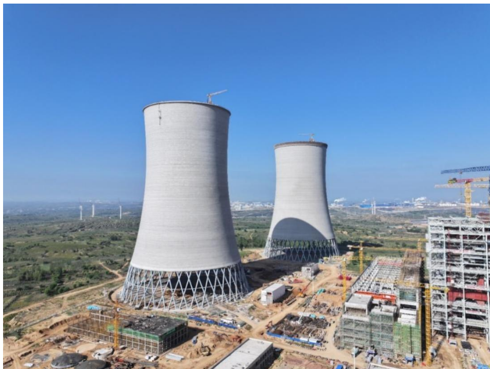
图4.6-6 神木神信热电厂1、2号机组间冷塔（塔高215m）
