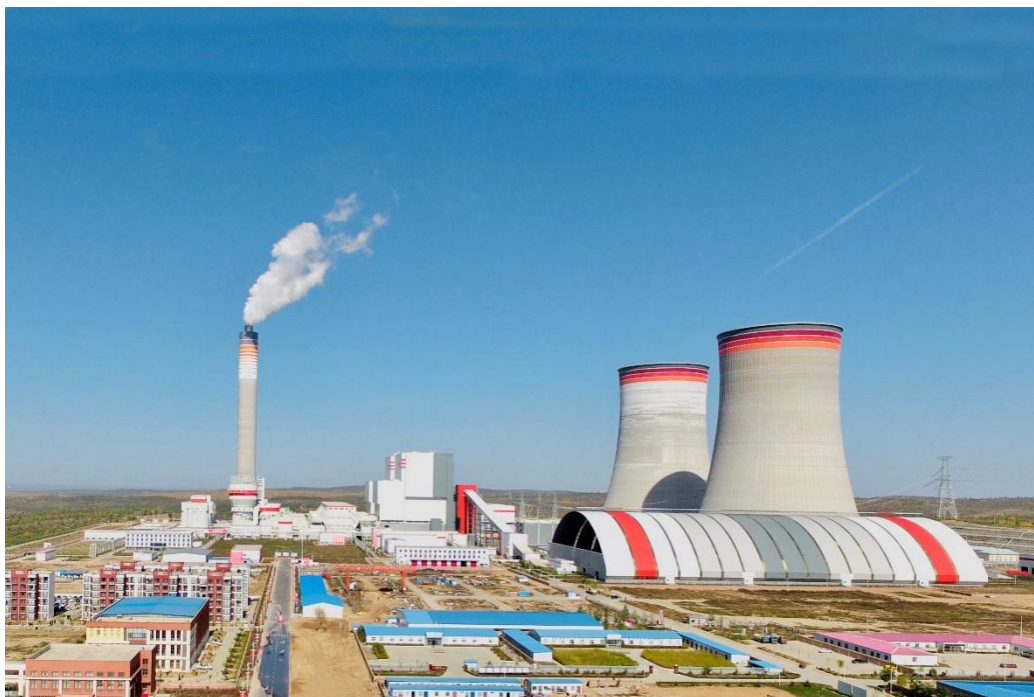
图4.6-4 陕能赵石畔煤电一体化项目雷龙湾电厂间冷塔（塔高204m）
