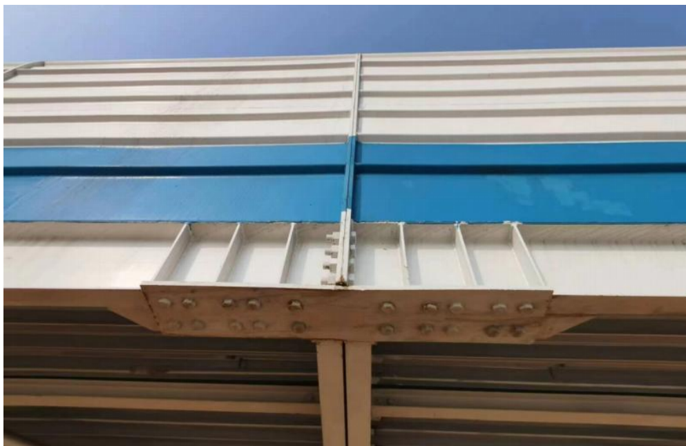
栈桥侧板连接节点
