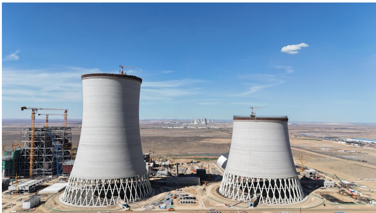
图4.6-9 新疆信泓电厂间接空冷冷却塔（塔高198m）
