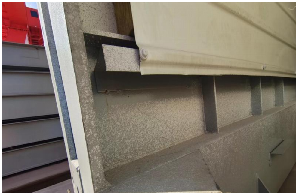
栈桥侧板防水构造
