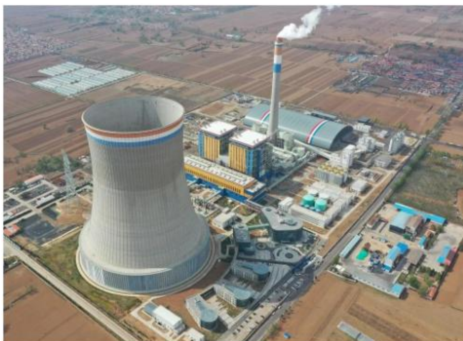
图4.6-5 山西潞安长子高河电厂间接空冷冷却塔图（塔高220m）
